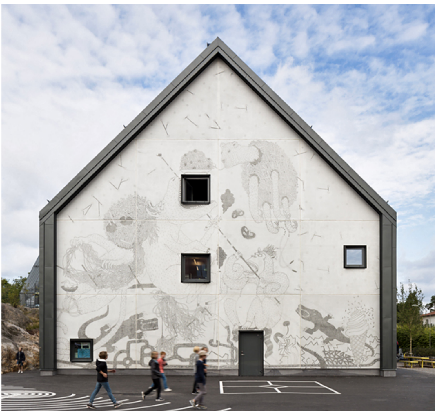
LÅNGBRODALSSKOLAN Stockholm, Sweden
